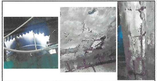
FOTO 6: EL TINACO ESTÁ EN TERRAZA Y COLUMNAS DETERIORADAS POR LA HUMEDAD Y EL PASO DEL TIEMPO, REQUIRIENDO FUNDICION NUEVA QUE SOPORTE EL PESO PARA QUITAR ESE PELIGRO
